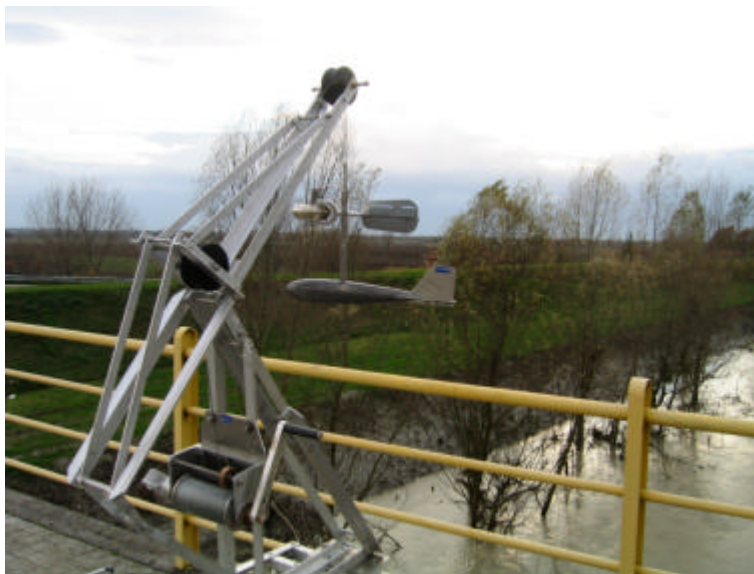
Figura 13 : Ponte sul Fiume Santerno (località la Giovecca).
