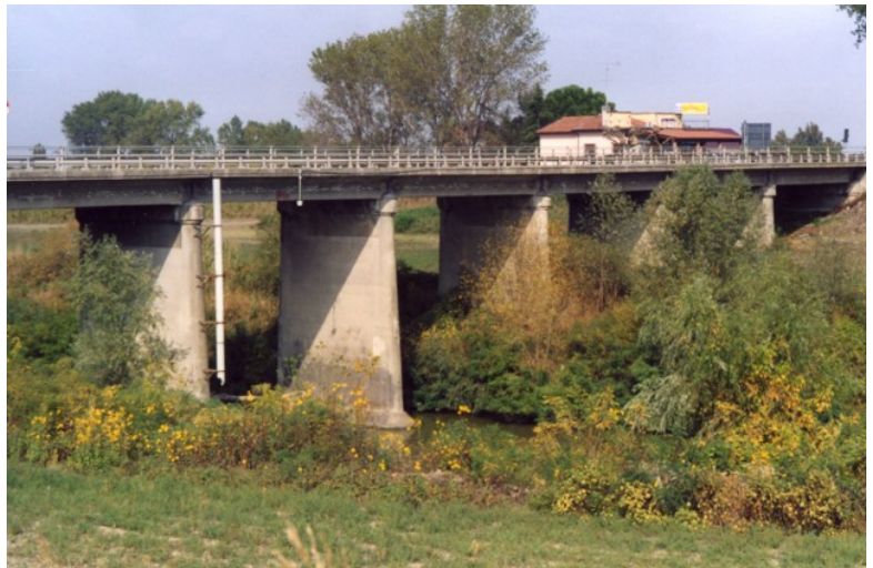
Figura 5 : Ponte della Bastia
